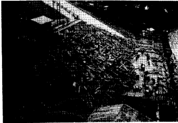
写真6 小牧ダムコンベアーから専用鉄道への木材積換え
